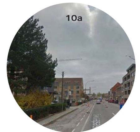
10a Brugsesteenweg B14m, dubbelrichting ruimte in parkeerstroken (2) (recent heraangelegd?)
