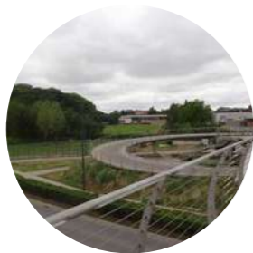
zicht richting Park Albert I-laan/ Veldstraat
