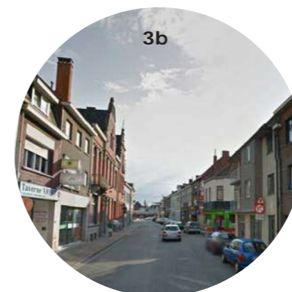
Ardooiesteenweg B11m, dubbelrichting ruimte in parkeerstrook (1)
