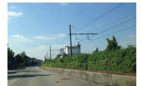
Spoorweg ten zuiden van het station
